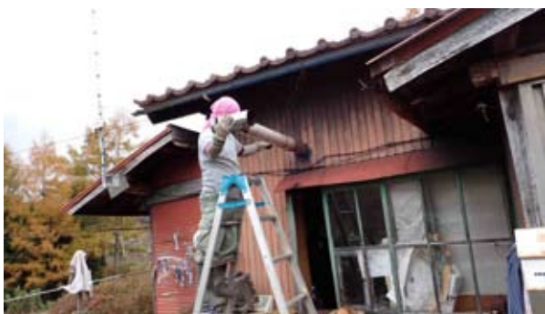
森の笠地蔵プロジェクトでは、薪ストーブの煙突掃除もします。
