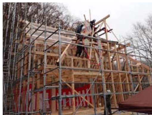
11月12日にオッホーの森の家の上棟式を行いました。
